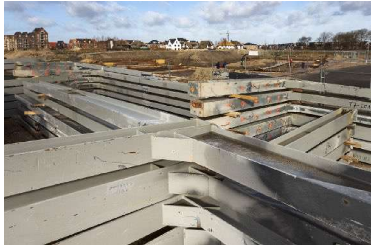
Foto Vic Obdam. Hergebruik staal
